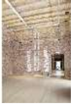
HchNS.II, Veranstaltungsräume (Rohbau), DI009730, BSV-
