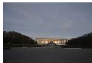
HchNS.I, Westfassade, im Vordergrund der Latona-Brunnen, DI006008, BSV-
