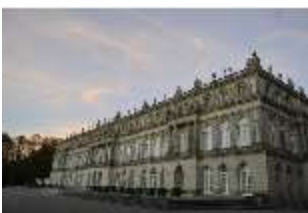
HchNS.I, Westfassade, Ansicht von Süd-Westen aus, DI006001, BSV-
