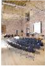
HchNS.II, Veranstaltungsräume (Rohbau), DI009726, BSV-
