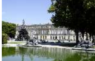
HchNS.V, Westl. Gartenachse, Wasserparterre, Westfassade, DI006194, BSV
