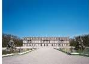
HchNS.I, Westfassade, DE000042, BSV-
