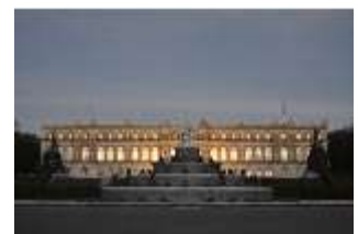
HchNS.I, Westfassade, im Vordergrund der Latona-Brunnen, DI006009, BSV-
