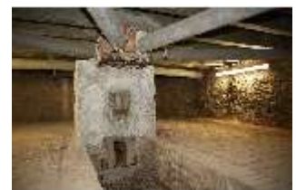
HchNS.II, Kellerraum, DI023680, BSV-
