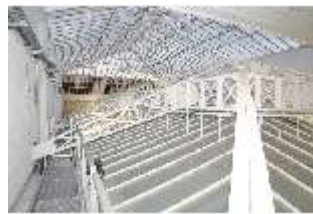
HchNS.II, Dachkonstruktion Treppenhaus, DI023682, BSV-
