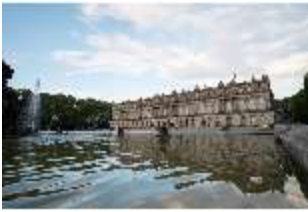
HchNS.I, südl. Bassin mit Westfassade, DI020461, BSV-
