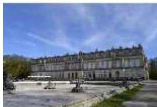
HchNS.I, Westfassade und südliches Bassin, DI005983, BSV-
