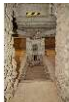
HchNS.II, Kellerraum, DI023679, BSV-
