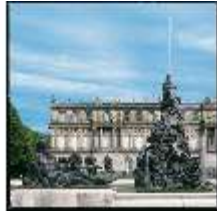
HchNS.I, Fassadendet., Fama-Brunnen, DE002742, BSV-
