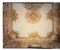
HchNS.II, Decke (Detail) des Arbeitszimmers des Königs, R. 15, DI008163, BSV-
