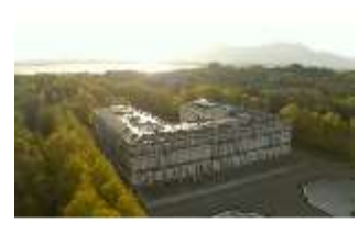
HchNS.I, Luftaufnahme, Gartenfassade, DI021054, BSV-
