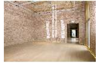
HchNS.II, Veranstaltungsräume (Rohbau), DI009729, BSV-
