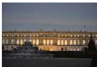
HchNS.I, Westfassade, im Vordergrund der Latona-Brunnen, DI006007, BSV-
