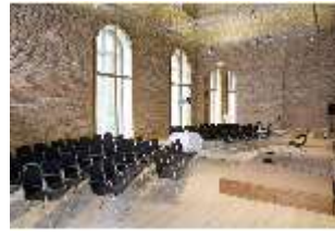
HchNS.II, Veranstaltungsräume (Rohbau), DI009728, BSV-
