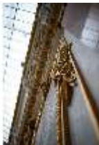
HchNS.II, Detail Wandgestaltung Prunktreppe, DI020476, BSV-
