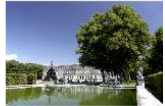
HchNS.V, Westl. Gartenachse, Wasserparterre, Westfassade, DI006192, BSV
