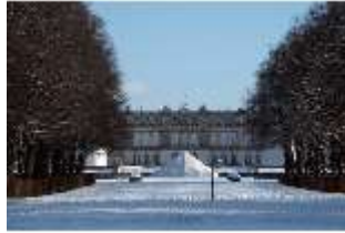
HchNS.V, Westfassade, Westliche Gartenachse, DI018887, BSV
