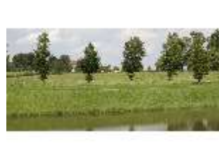
HchNS.V, Westachse, Kanal, Blick auf die umliegende Landschaft, DI006236, BSV
