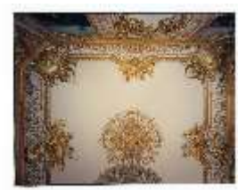
HchNS.II, Decke (Detail) des Arbeitszimmers des Königs, R. 15, DI008164, BSV-
