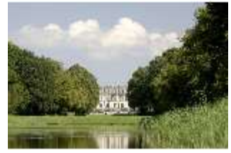
HchNS.V, Westfassade vom Kanal aus, DI006205, BSV
