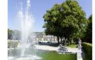
HchNS.V, Westl. Gartenachse, Wasserparterre, Westfassade, DI006195, BSV
